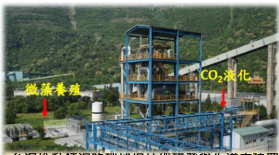
台泥推動鈣迴路碳捕捉技術研發與先導廠建置與工研院合作，建置鈣迴路CO 2 捕捉3,000噸/年先導廠，規劃放大至10萬噸/年示範廠(2030年)，初期可供微藻養殖固碳，轉製高價值蝦紅素
