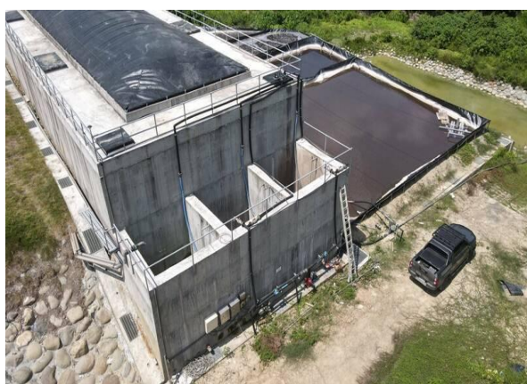
內門畜牧廢水資源化中心沼氣回收
