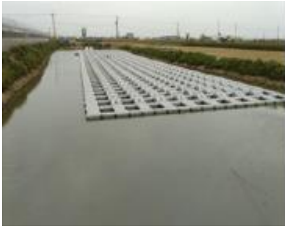
圖 4、室外水產養殖設施結合太陽能光電示意圖
