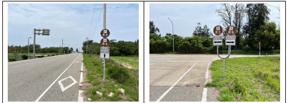
圖 2-6、自行車專用車道及 U 型桿標誌牌立柱
