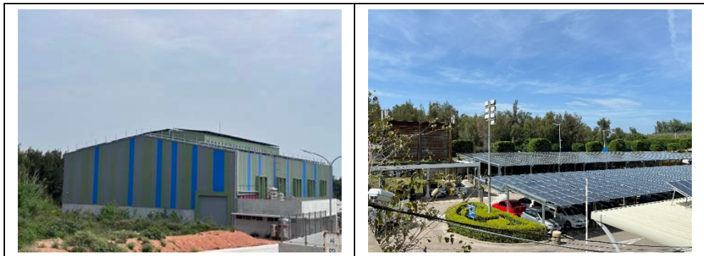
圖 2-1、新塘倉儲廠及環保局停車場太陽光電裝置場域
