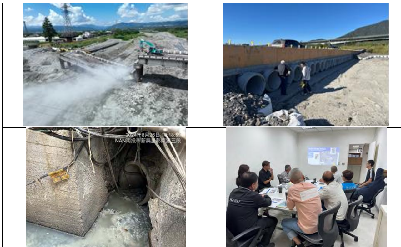
圖12、維生基礎設施執行情形
