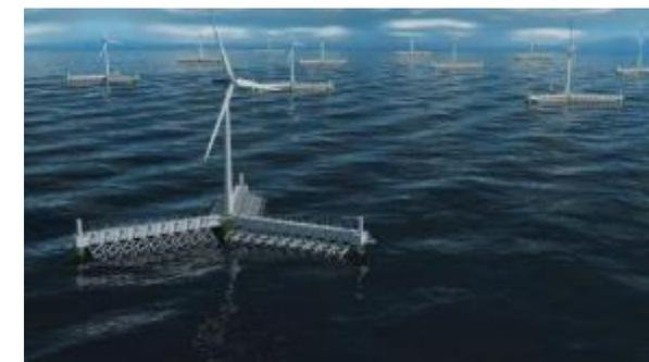
複合式電廠示意圖 (風能+波能)
