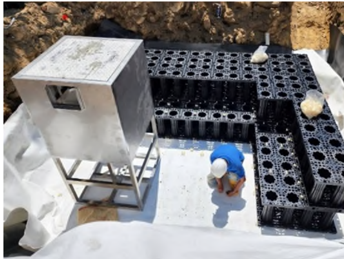
圖 3.3- 4 不鏽鋼檢視井示意圖
